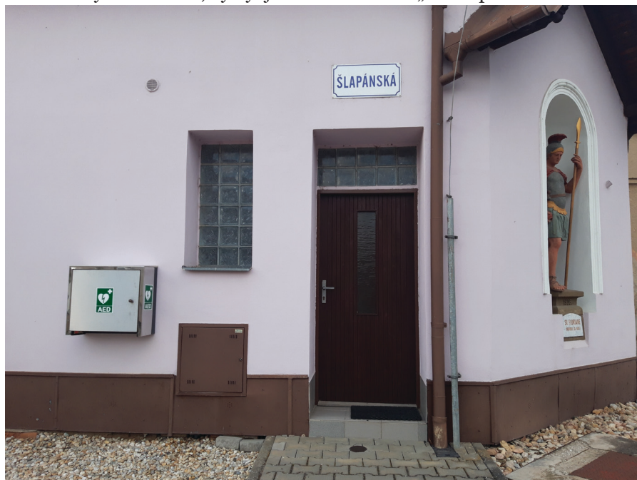
Umístění boxu s AED na zbrojnici
